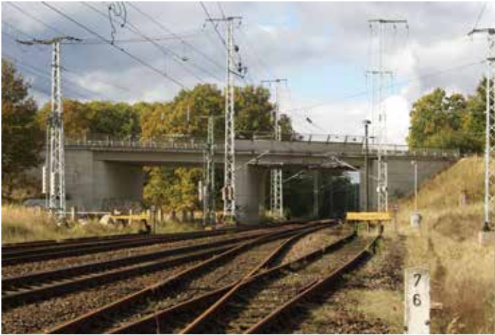
Wiederaufgebaut: Die alte Brücke über die Bahnschienen bei Adamsdorf kurz vor dem Abriss
